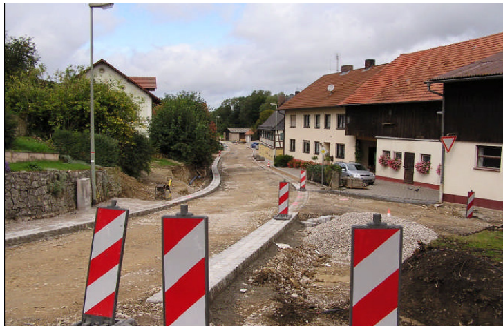
Ortsdurchfahrt während der Baumaßnahme
